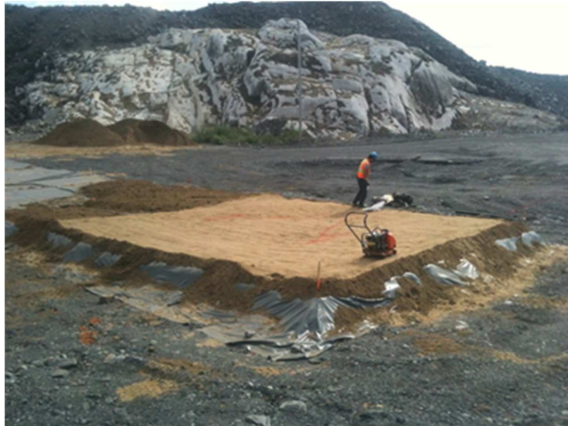
Figure 2.11 Compaction de la couche de sable de protection supérieur du lysimètre 1 à l'aide d'une plaque vibrante
