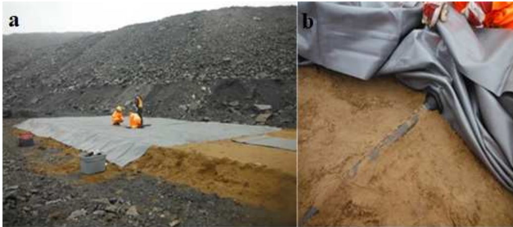
Figure 2.7 Mise en place de la géomembrane sur la couche de sable de protection inférieure du lysimètre 1 (a) et son raccordement au drain de collecte des eaux de drainage (b)
