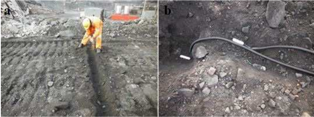
Figure 2.20 Tranchées creusées dans les stériles du haut de la halde (a) et installation des sondes de teneur en eau et de succion dans ces tranchées (b)
