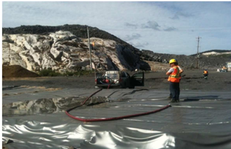
Figure 2.9 Test d'étanchéité des drains des lysimètres
