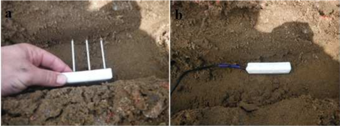
Figure 2.10 Installation de la sonde de teneur en eau volumique “ Decagon GS3” dans la couche de sable de protection supérieure
