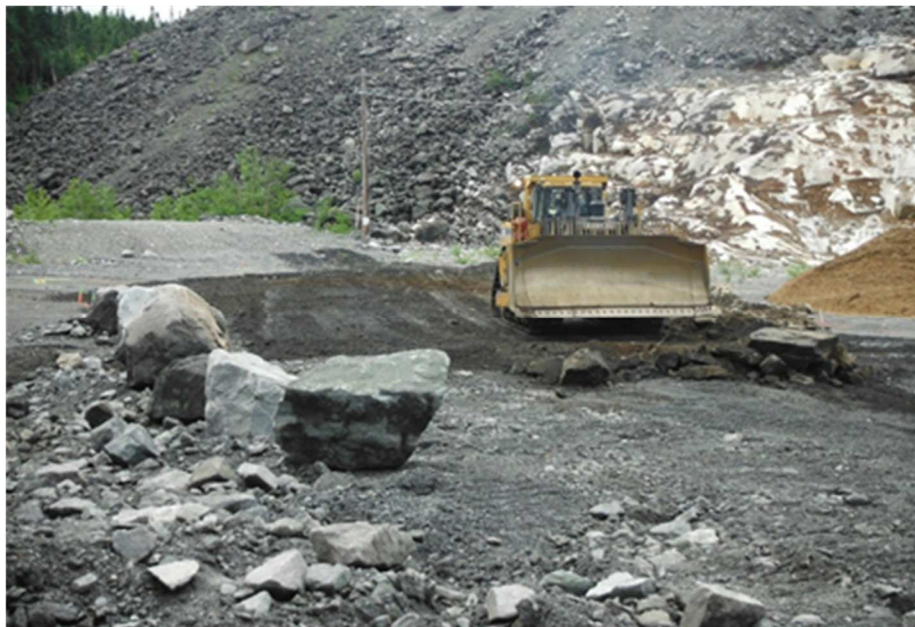
Figure 2.3 Nivellement de la surface devant accueillir la halde expérimentale
