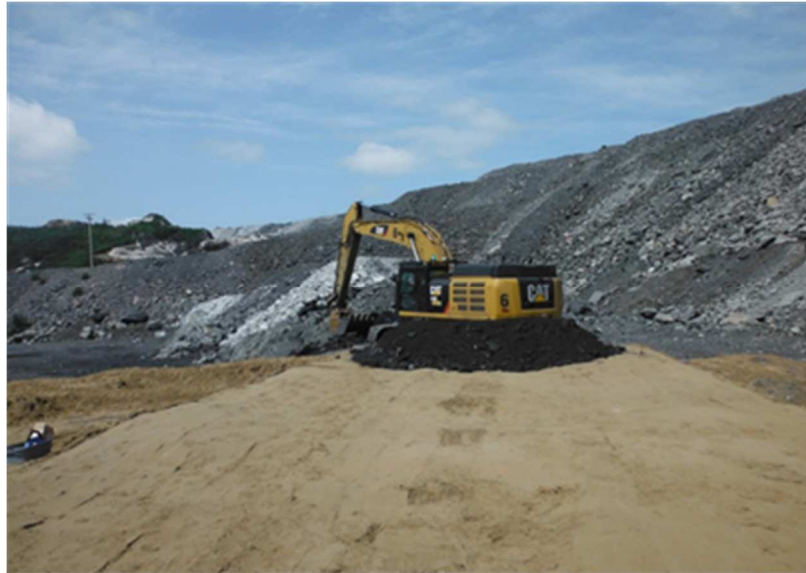
Figure 2.14 Mise en place d'une couche de stériles minéralisés de protection sur les lysimètres à l'aide d'une excavatrice
