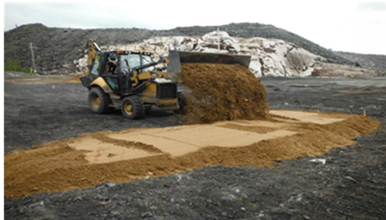
Figure 2.4 Mise en place de la couche de sable de protection inférieur du lysimètre 1
