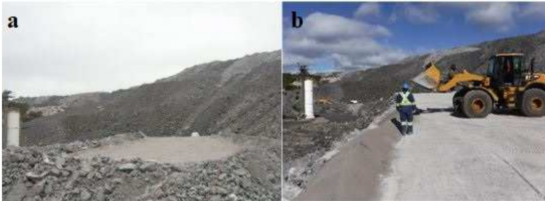
Figure 2.21 Aperçu de la surface de la halde expérimentale bordée par les bermes de gauche, de droite et de l'avant (a) et mise en place des bermes de sécurité (b)
