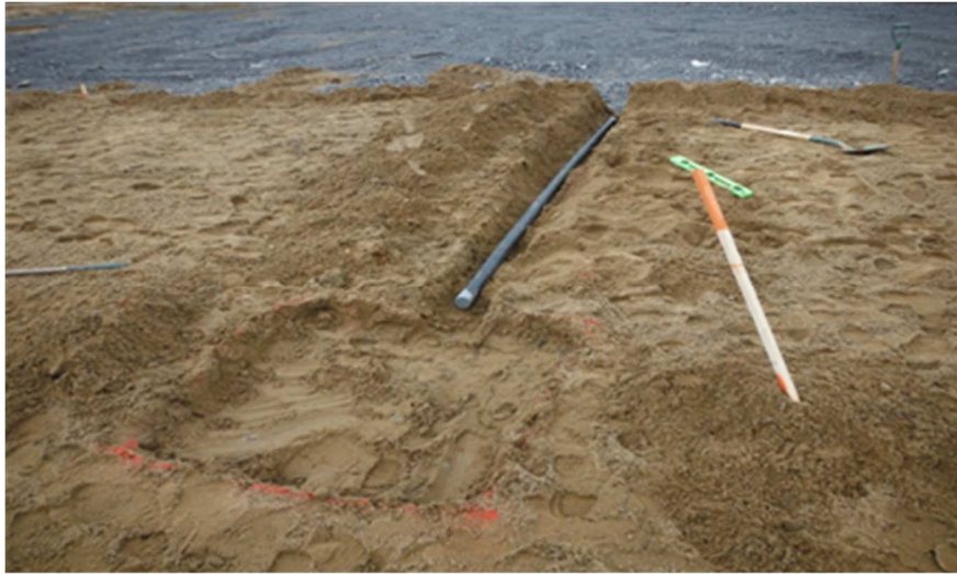
Figure 2.5 Installation du drain de collecte des eaux dans un des six lysimètres
