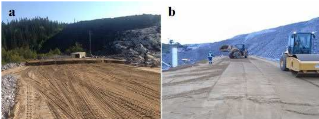
Figure 2.25 Mise en place et compaction du sable de la deuxième levée
