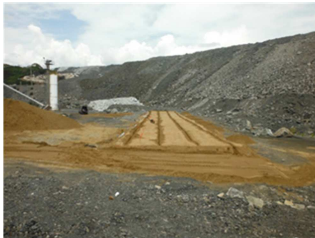
Figure 2.13 Tranchées pour l'installation du câble DTS
