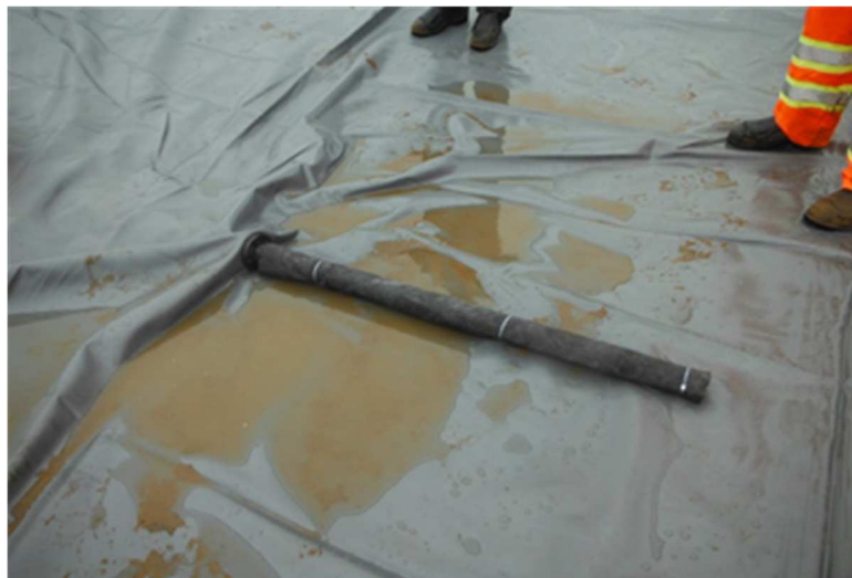
Figure 2.8 Mise en place de la crépine
