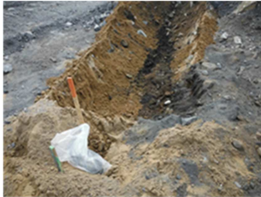
Figure 2.15 Excavation pour l'installation des débitmètres
