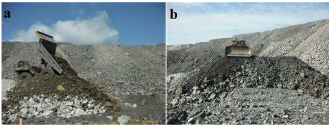
Figure 2.18 Déversement de stériles du haut de la rampe d'accès à l'aide d'un camion de 100 tonnes (a) et utilisation d'un bulldozer pour les pousser vers le bas
