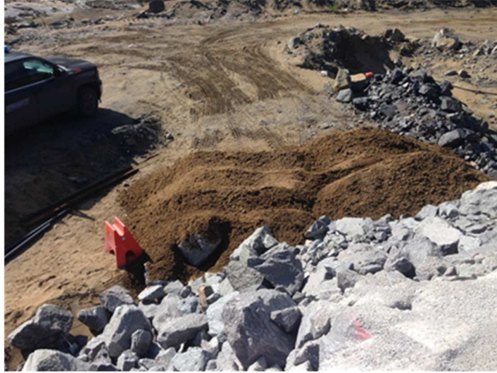
Figure 2.27 Construction d'une rampe d'accès pour les travailleurs
