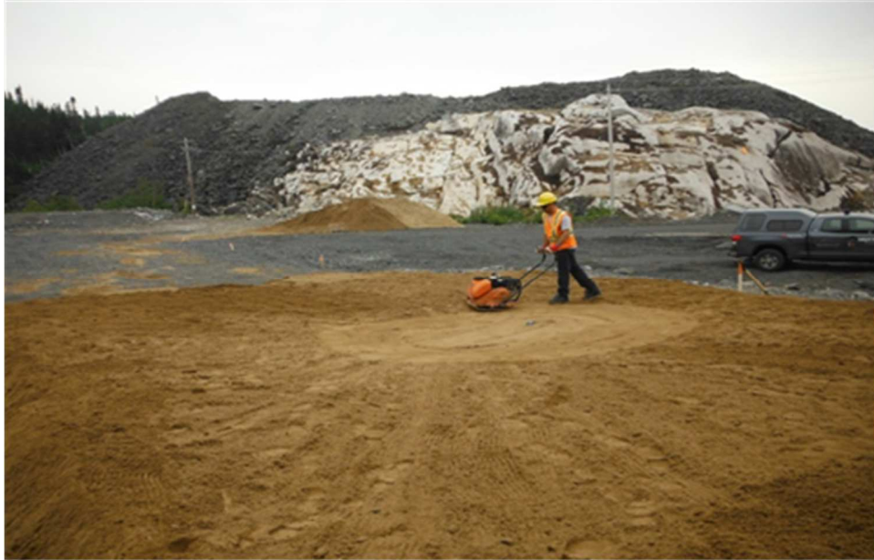
Figure 2.6 Compaction de la couche de sable de protection inférieure du lysimètre
