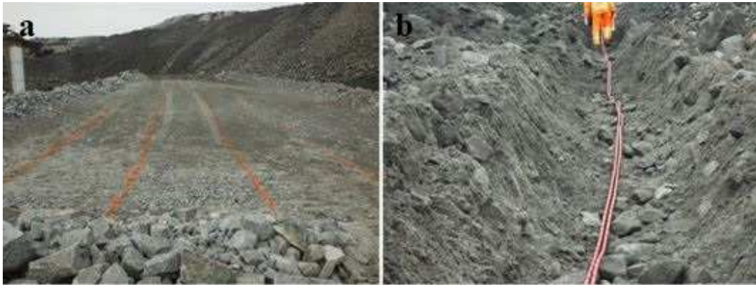
Figure 2.19 Repères sur la surface des stériles de la halde pour l'installation future des câbles DTS (a) et mise en place du câble DTS dans les stériles (b)
