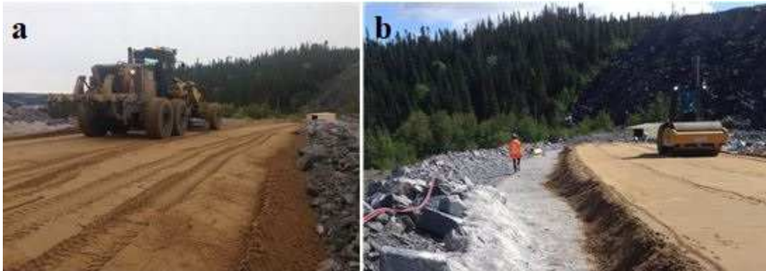
Figure 2.23 Nivellement (a) et compaction de la première levée de sable (b)
