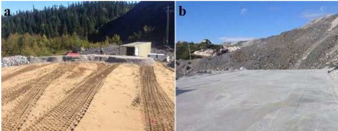
Figure 2.26 Début de la mise en place de la couche de matériaux fins anorthositiques concassés et sa compaction (surface finale de la halde expérimentale)
