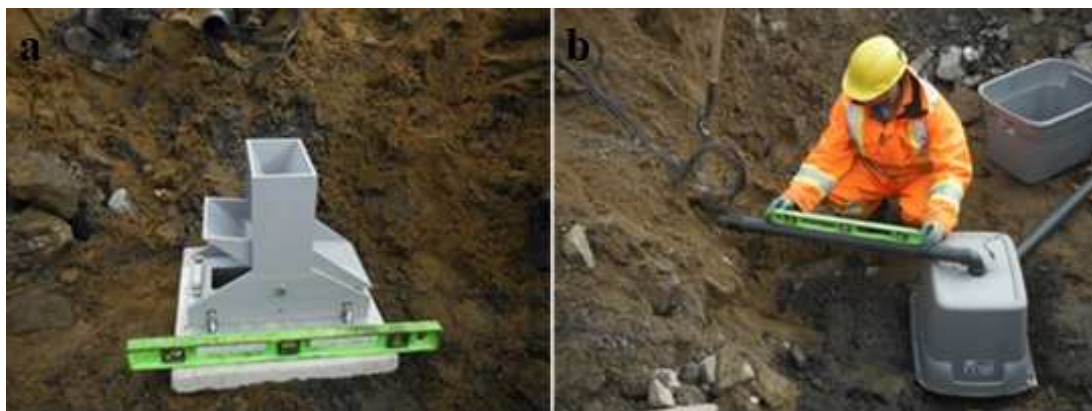
Figure 2.16 Installation d'un débitmètre à bascule
