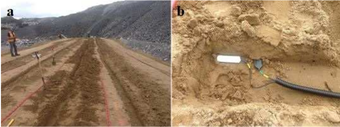
Figure 2.24 Tranchées pour l'installation du câble DTS (a) et installation des sondes de teneur en eau et de succion (GS3 et MPS2 Decagon) (b)
