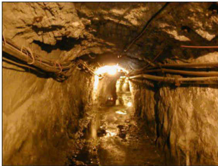
FIGURE 1. 1 — Galerie minière du niveau 70 m sous terre.
