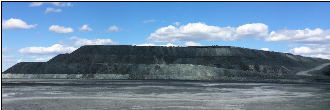
Figure 3.2 : RSF-de Portage vue du sud-ouest de la halde (photo du 12 juillet 2016)
