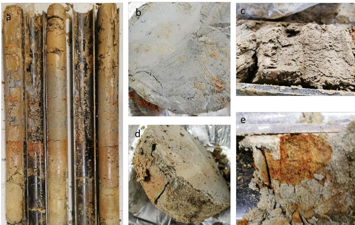
Figure 3.12: Photos des échantillons des matériaux prélevés de parc 3 Est du site
