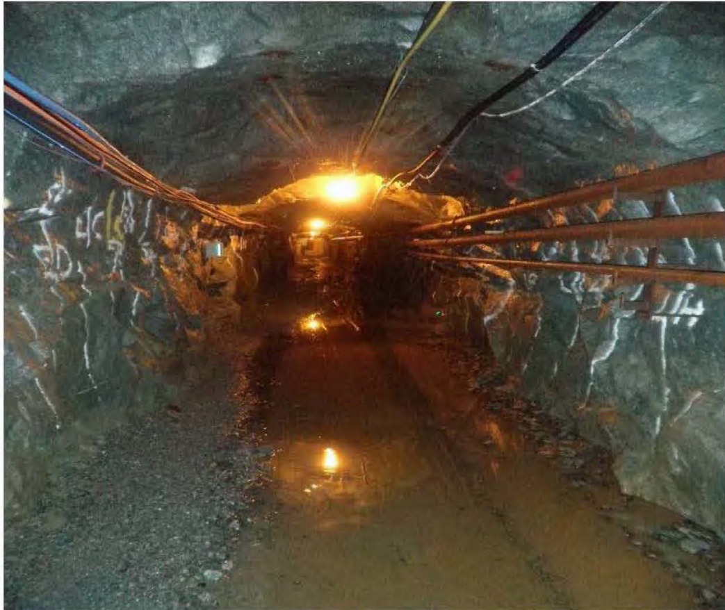
Figure 4-4:Galerie minière au niveau 70m
