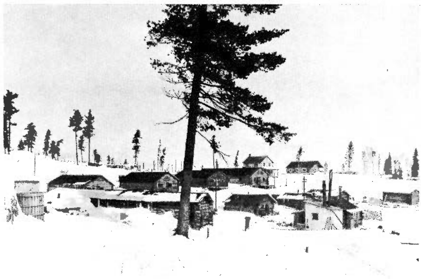
Les premières installations de la mine Horne en février 1926.
