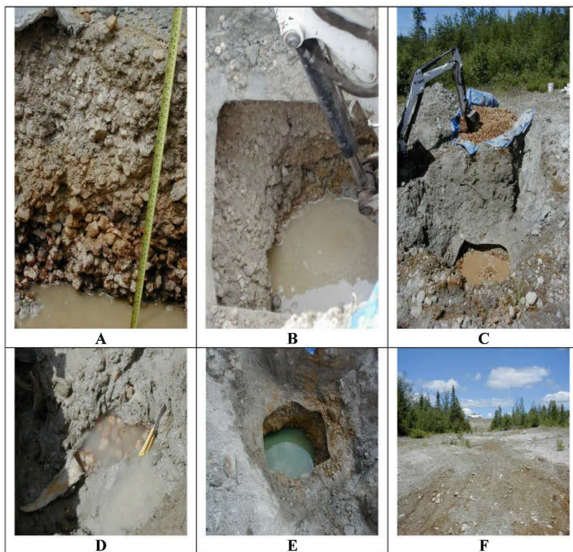
Figure 4.16 : Planche de photos des tranchées 1 à 5 illustrant les principaux phénomènes observés : A) Paroi du drain, on peut observer la différence de couleur de la pierre dolomitique saturée (couleur orangée) et non saturée (couleur blanchâtre) qui indique le niveau de l'eau dans le drain; B) Paroi de TR-2, elles sont très lâches; C) Dépôt sur une toile de la pierre dolomitique retirée du drain Dol-1 (Tr-3); D) Dol-3, TR-5 inondé d'eau sous la géo membrane; E) Injection du traceur de sodium avec colorant bleu dans Tr-4; F) État du terrain tel que laissé après les travaux (Photographies tirées de St-Arnault et al. , 2005)
