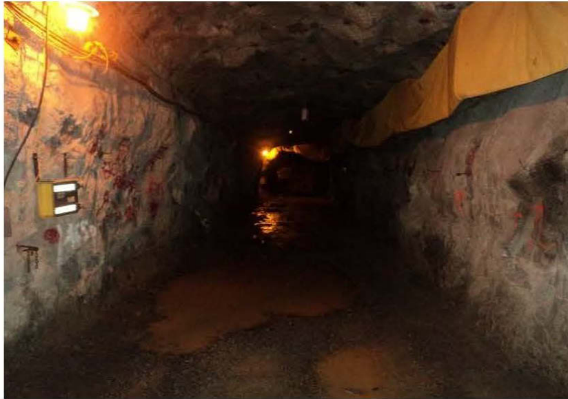
Fig. 2.8. Une galerie de la mine CANMET au "niveau 40 m".
