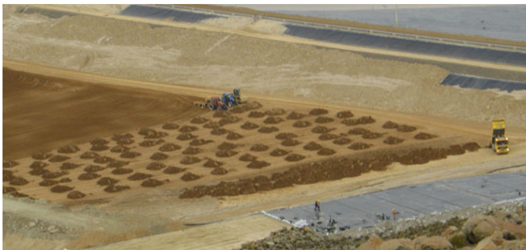
Figure 2.10. Empilement en surface, à l'aide des bennes, des résidus miniers fins filtrés : cas de la mine Copia dans la région sèche de l'Atacama au Chili (adaptée de www.tailings.info )
