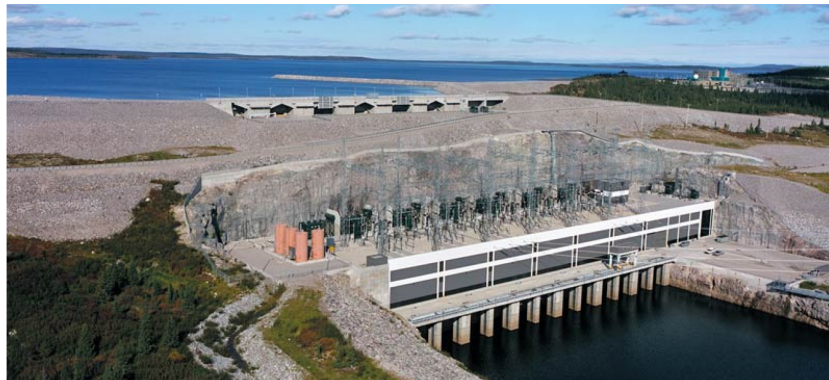
Figure 2-2 : Centrale hydroélectrique à la base du SACH : Laforge-11, Québec
