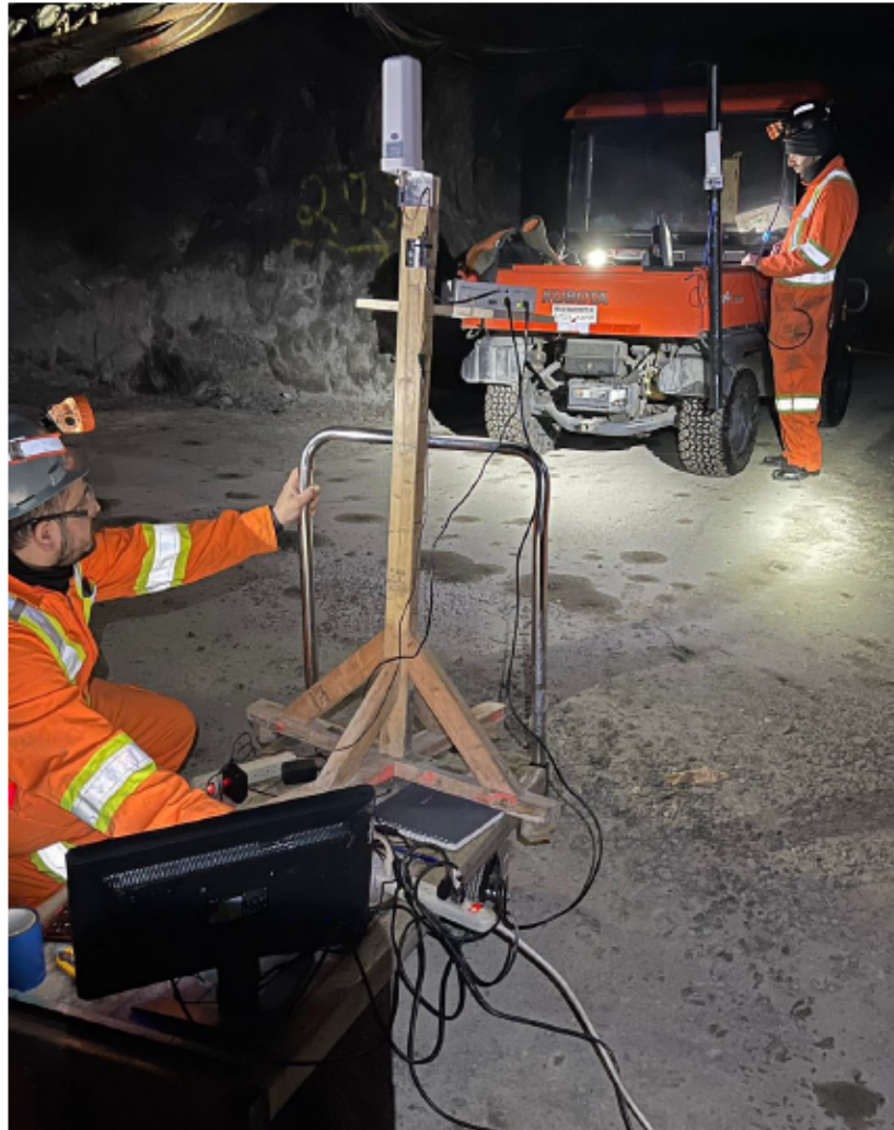
Figure 30 : Installation des matérielle dans la mine
