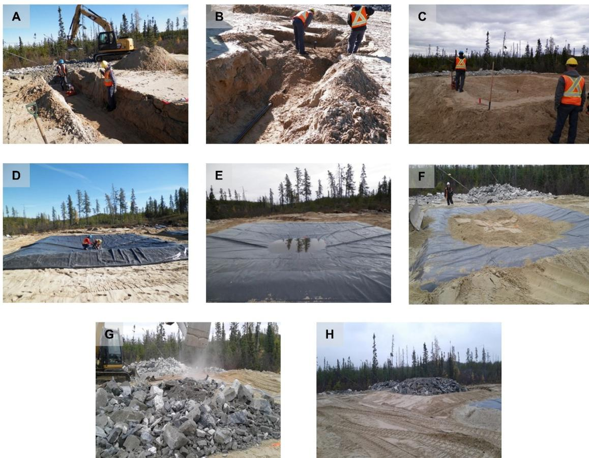
Figure 3.16 Étapes de la construction de la cellule de roches stériles seules. A) Excavation d'une tranchée pour le drain. B) Mise en place du drain et remplissage de la tranchée. C) Mise en forme et compactation de l'empreinte de la cellule. D) Installation de la géomembrane et connexion du passe-paroi avec le drain. E) Test d'étanchéité. F) Remplissage du lysimètre avec du sable. G) Remplissage de la cellule. H) Vue générale de la cellule achevée.
