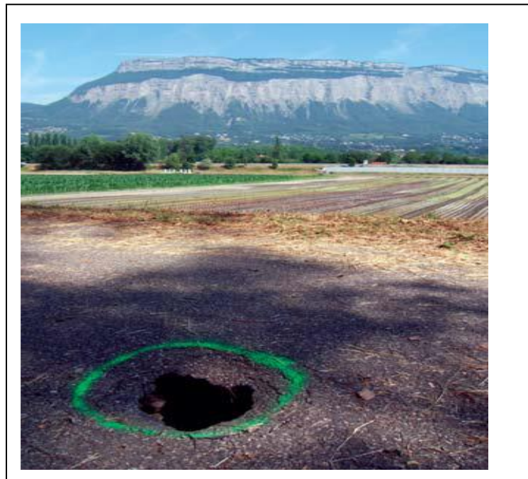
Figure 2.9 Effondrement en crête de digue lié à la décomposition d'une souche (tirée de Vennetier et al., 2015a)
