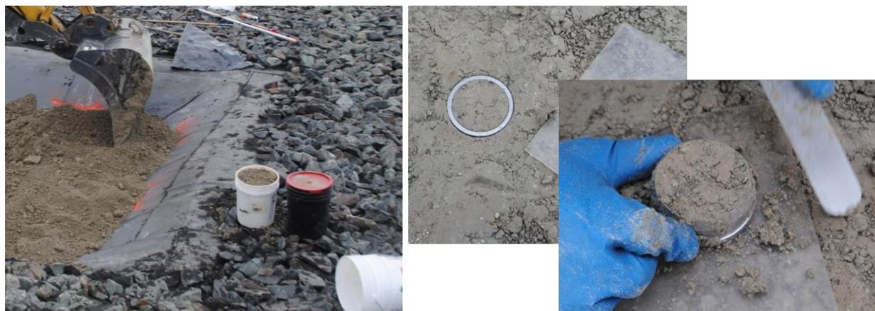
Figure 3-14 Types d'échantillon prélevés lors de la mise en place des cellules. À gauche les échantillons à grand volume et à droite les échantillons du cylindre échantillonneur.
