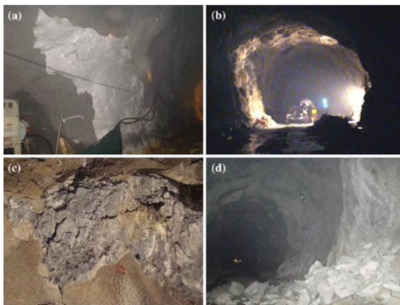
Figure 2-19 Exemples d'éclatement des roches dans les galeries de mines souterraines (Jiang et al., 2010)
