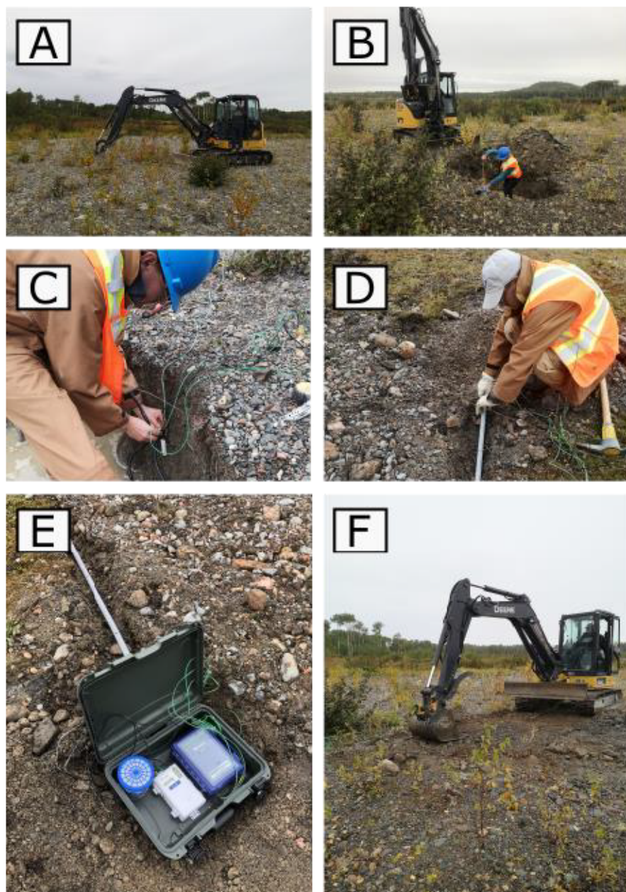
Figure 3.9: Étape d'installation des stations de suivis. A) Excavation d'une tranchée de 1 m de profond B) Observation visuelle de la tranchée. C) Installation des sondes de succion et de TEV. D) Installation des câbles de protection. E) Installation des systèmes d'acquisition. Ceux-ci ont été enfouis dans un boîtier étanche. F) Remblayage de la tranchée.
