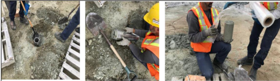
Figure 3.3 Représentation du processus de carottage
