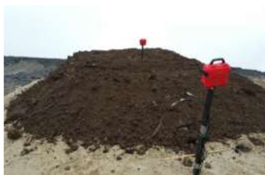
j) Mise en place de la couche de mort-terrain/tourbe sur la cellule ELCP-1
