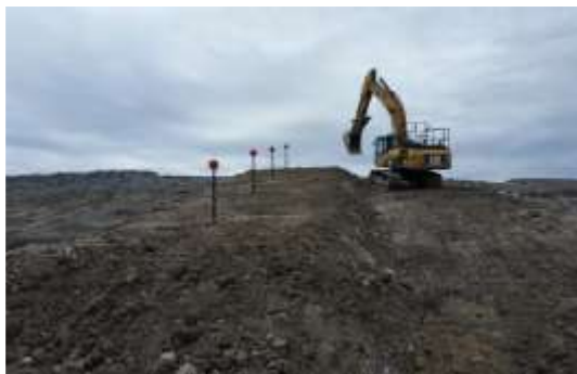
g) Mise en place de couche de till sur la cellule ELCP-1
