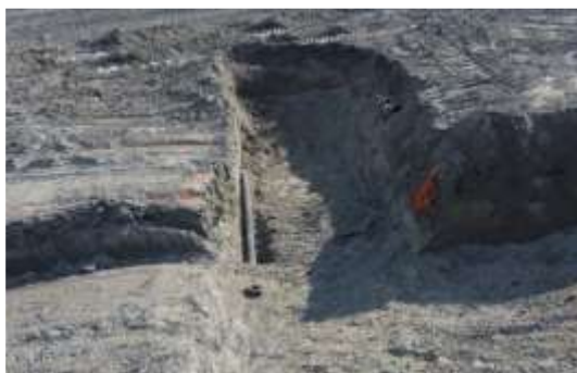
c) Installation des drains de collecte
