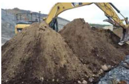
i) Fabrication du mélange mort-terrain/tourbe
