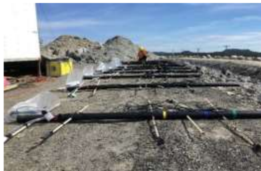
b) Fabrication des arbres à sondes
