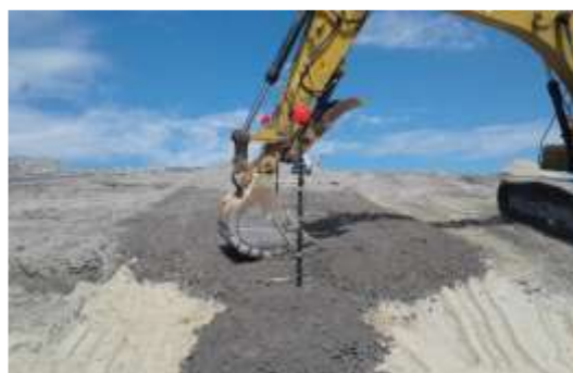
f) Mise en place de la couche de stériles miniers
