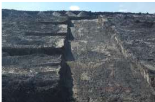
a) Cellule ELCP-1 excavée
