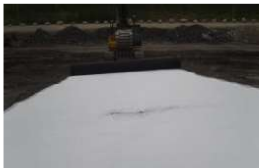
d) Installation des géomembranes sur les cellules
