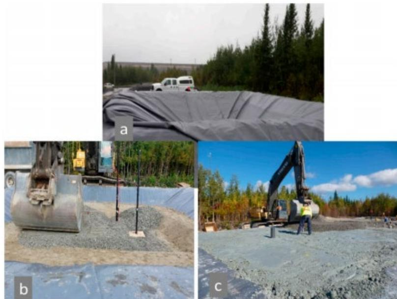
Figure 2.7 Installation de la géomembrane (a) et installation des différentes couches de la cellule expérimentale de terrain (b) et (c) (tirée de Kalonji-Kabambi et al. 2020)
