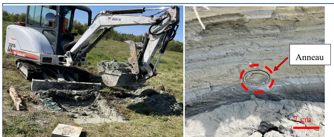
Figure 3.7 Zone d'excavation et de prélèvement d'échantillons pour la caractérisation géotechnique du profil des résidus Goldex
