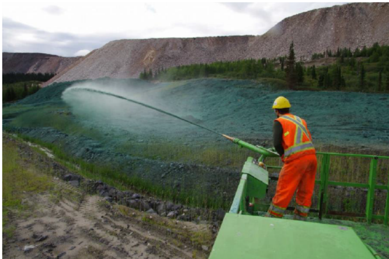
Figure 2-1 Travaux d'ensemencement hydraulique réalisés sur la mine du Mont-Wright au mois d'août 2015 par la compagnie Irrigation NORCO Inc. Tiré de l'annexe L du plan de restauration de la mine du Mont-Wright (WSP, 2017).
