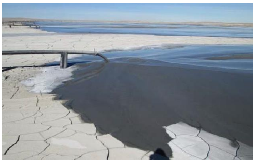
Figure 2.7 Entreposage de résidus miniers sous forme épaissie dans un parc à résidus (ministère des Mines du Chili, 2021).
