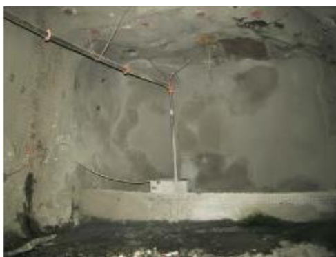
Figure 2.12 Barricades en béton projeté (McDonald & Hutter, 2014)
