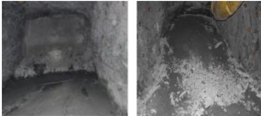
Figure 2.13 Barricades de stériles rocheux (tirée de Belem et al., 2020)
