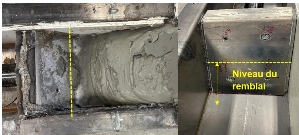
Figure 4.20 Vue de dessus du RPC au niveau de la galerie près de la barricade
