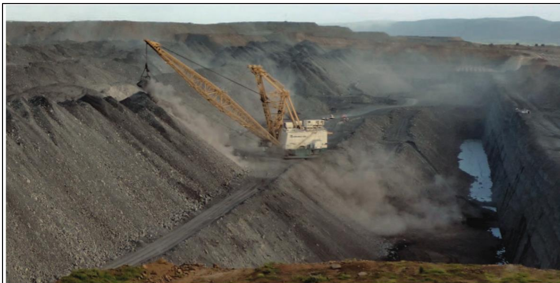
Figure 2.3 Utilisation de la pelle à benne traînante ( dragline ) pour un empilement contrôlé des matériaux dans une exploitation à grande échelle (Hawley et al., 2017).
